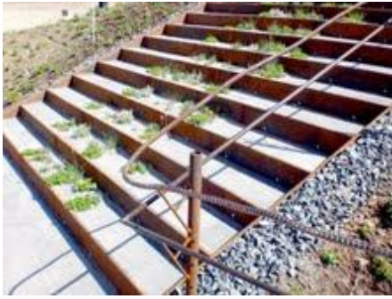
KUVA 4. Ekoluoto, käytetystä metallista hitsatut portaat. Kaiteet romuraudasta.
