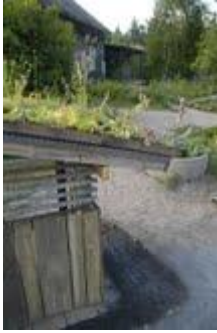
KUVA 15. Kotalato, Perniön taimisto, roskakatoksen viherkatto sekä asuinrakennuksen lisäsiiven viherkatto.
