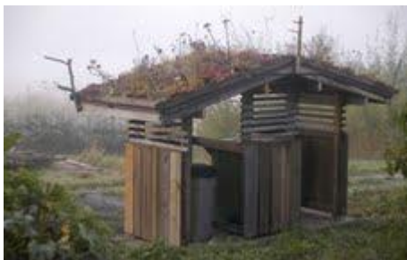
KUVA 14. Kotalato, Perniön taimisto, oman roskakatoksen viherkatto.
