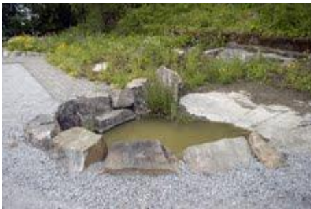
KUVA 5. Ekoluoto, salaojia myöten johdetaan hulevesiä imeytysaltaaseen. Kosteikkokasveja.
